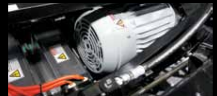
Слева под кабиной виден электромотор насоса гидроусилителя руля. Перед ним — два электрических отопителя
